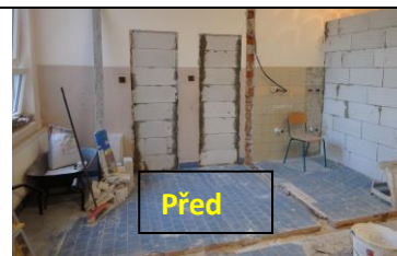
Rekonstrukce cvičné kuchyňky
